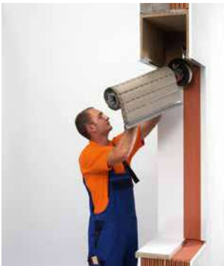
Alten Rollladen aus dem Kasten entfernen.
