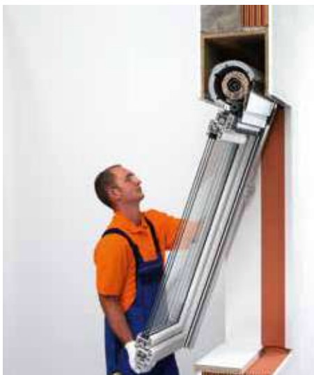
Fenster mit TERMO einsetzen.
